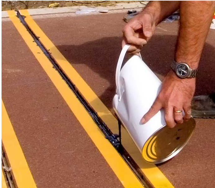
Pouring the PU200
